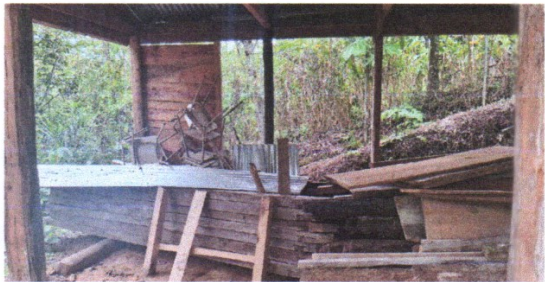
Foto 2: Mejoramiento de piso
