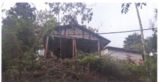
Foto 6: Mejoramiento de lámina
