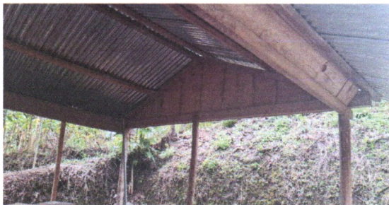
Foto 3: Mejoramiento de techo
