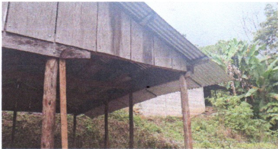
Foto 4: Mejoramiento de ventana y balcon
