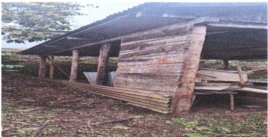
Foto 5: Mejoramiento de puerta
